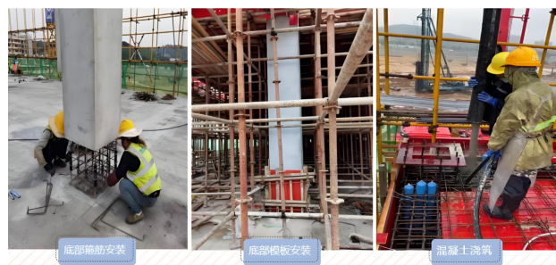
> 图2 预制空腔柱施工流程
